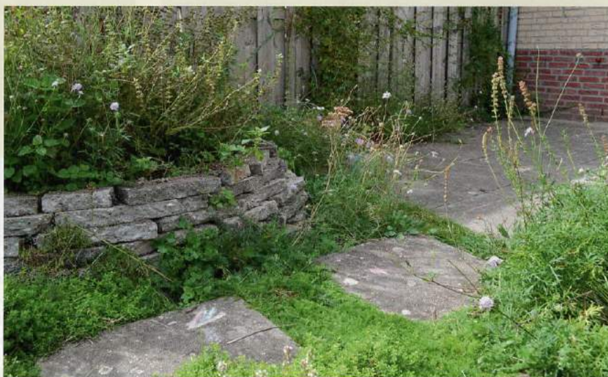
Met een stapelmuur creëer je extra ruimte voor planten om zich te vestigen: hier groeien in de muur onder meer Sedum acre en Campanula portenschlagiana . Oosthoek heeft voor de muur oude 30x30 tegels gebruikt uit de bestaande tuin.
